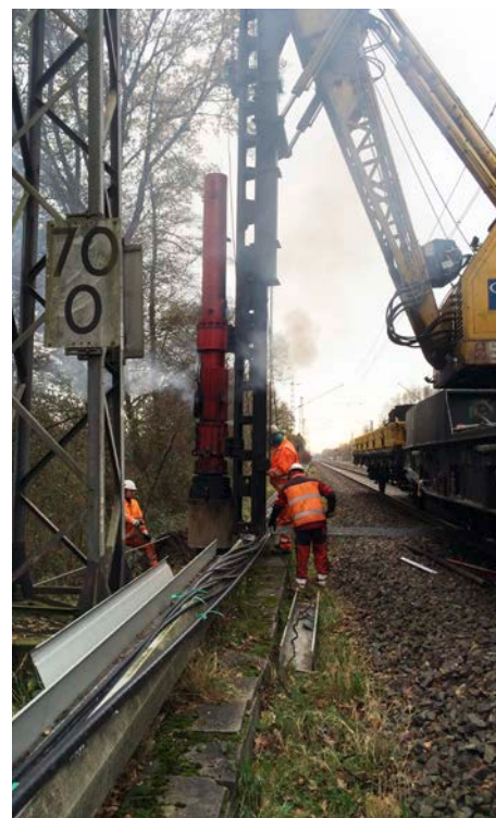
375 neue Oberleitungsmaste wurden gebaut.
