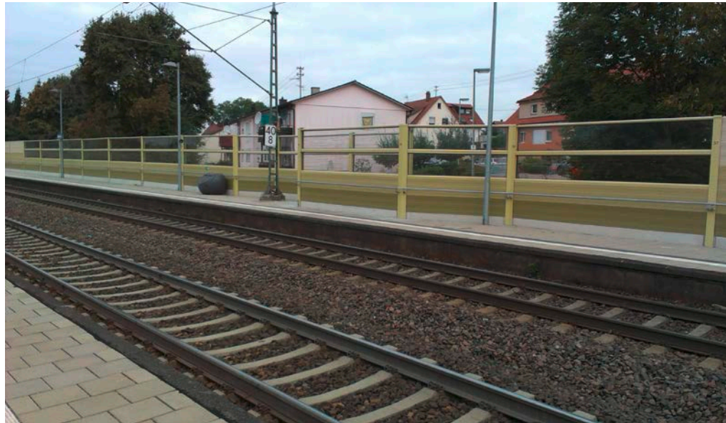
Beispiel für eine Schallschutzwand mit durchsichtigen Elementen
